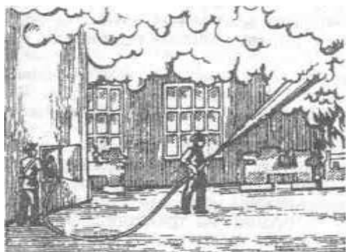
Рис. 1. Работа со стволом от внутреннего пожарного крана
